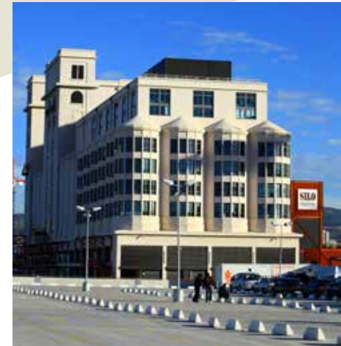
La salle de spectacle du Silo
